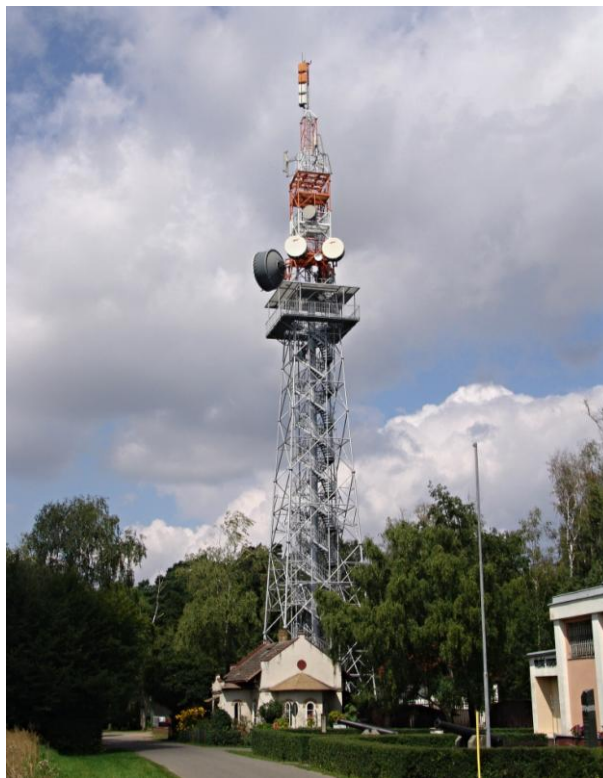
Rozhledna na telekomunikační věži z r. 1999
